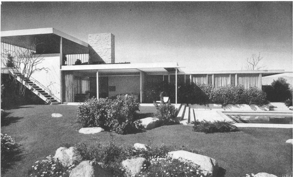
Bild 4. Ansicht aus Süden: Dachterrasse, Wohnraum, Elternschlafzimmer, davor Schwimmbaden
