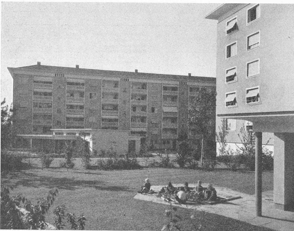
Bild 3. Blick von Osten, Standpunkt beim östlichen Kindergarten
