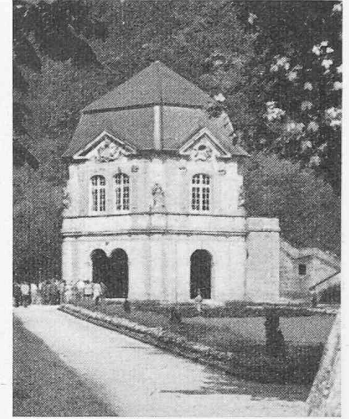
Pavillon im Park an der Sauer Besichtigung der Wiederaufbau-Arbeiten in Echternach
