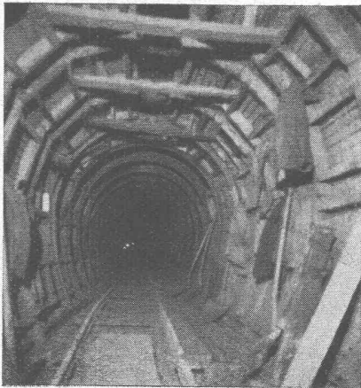
1140 m Stollen mit 30 lfm Schalung
