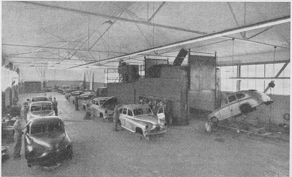
Bild 18. Montage der Karosserie im Obergeschoss
