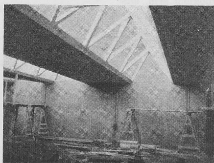
Bild 4. Das Dach von unten
