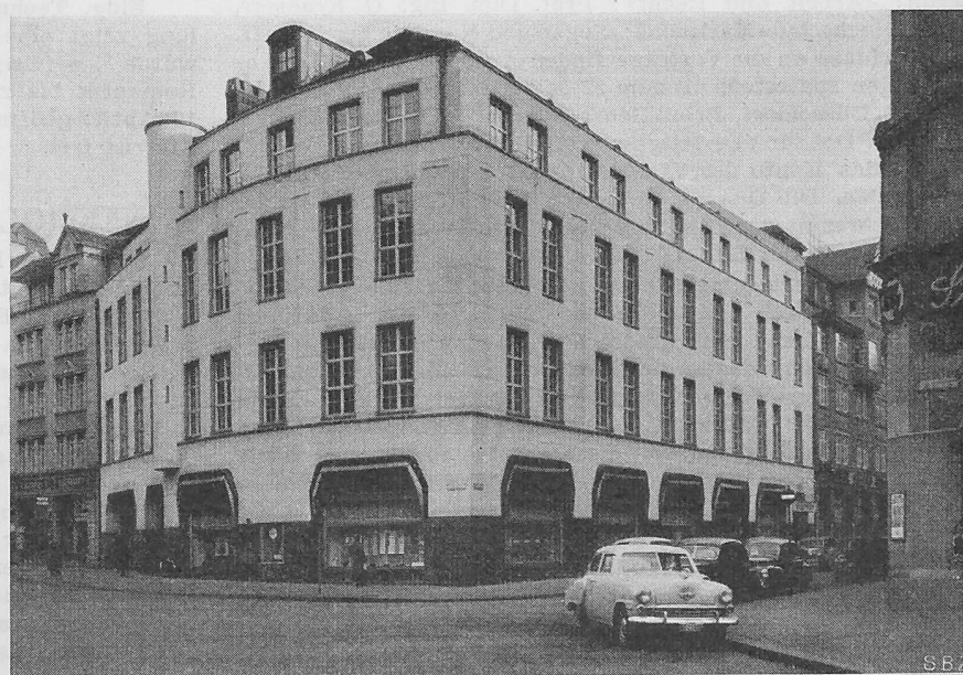
Bild 5. Telephonegebäude Füsslistrasse, 1925, Arch. PFLEGHARD &amp; HAEFELI
