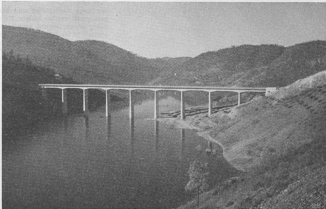
Bild 23. Strassenbrücke «Vale da Urça», 35 km oberhalb der Staumauer. 300 m lang, Fahrbahn 50 m über Talweg, Eisenbeton-Gerber-Träger mit 30-m-Oeffnungen, Pfeiler unarmiert
