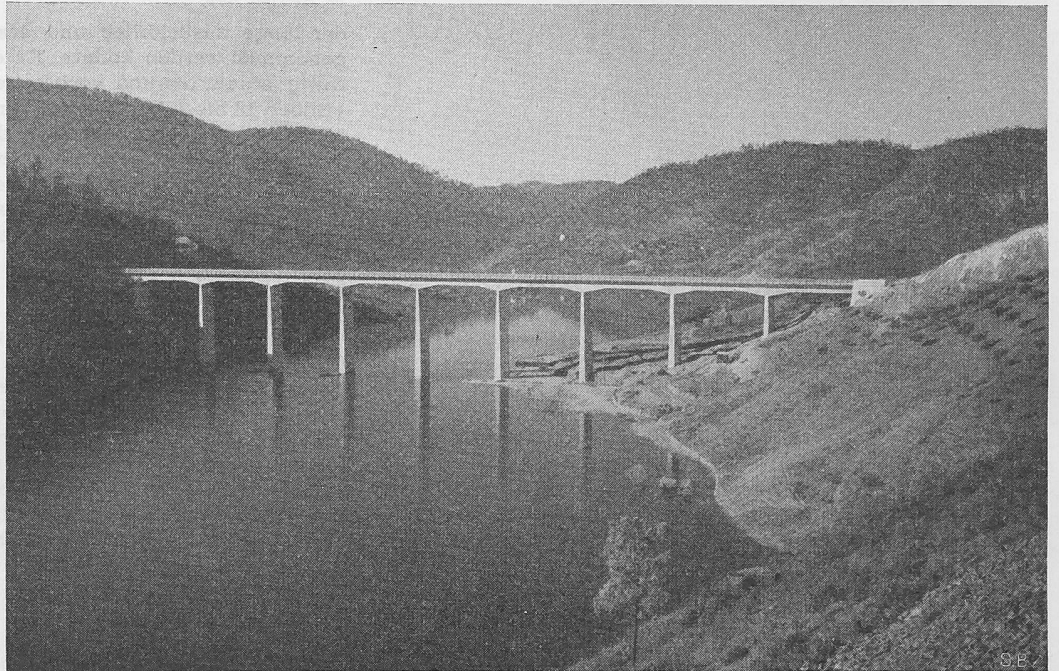
Bild 23. Strassenbrücke «Vale da Urça», 35 km oberhalb der Staumauer. 300 m lang, Fahrbahn 50 m über Talweg, Eisenbeton-Gerber-Träger mit 30-m-Oeffnungen, Pfeiler unarmiert
