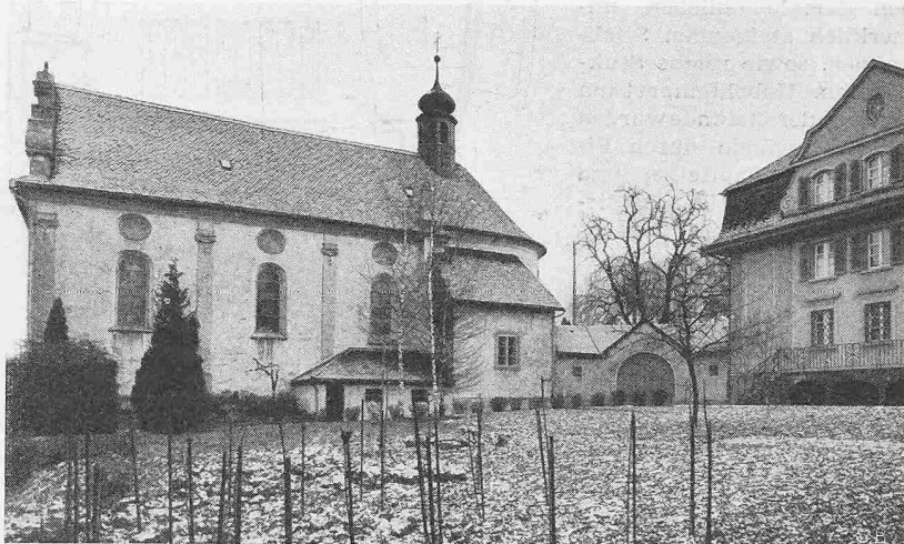
Westansicht vor der Restauration
