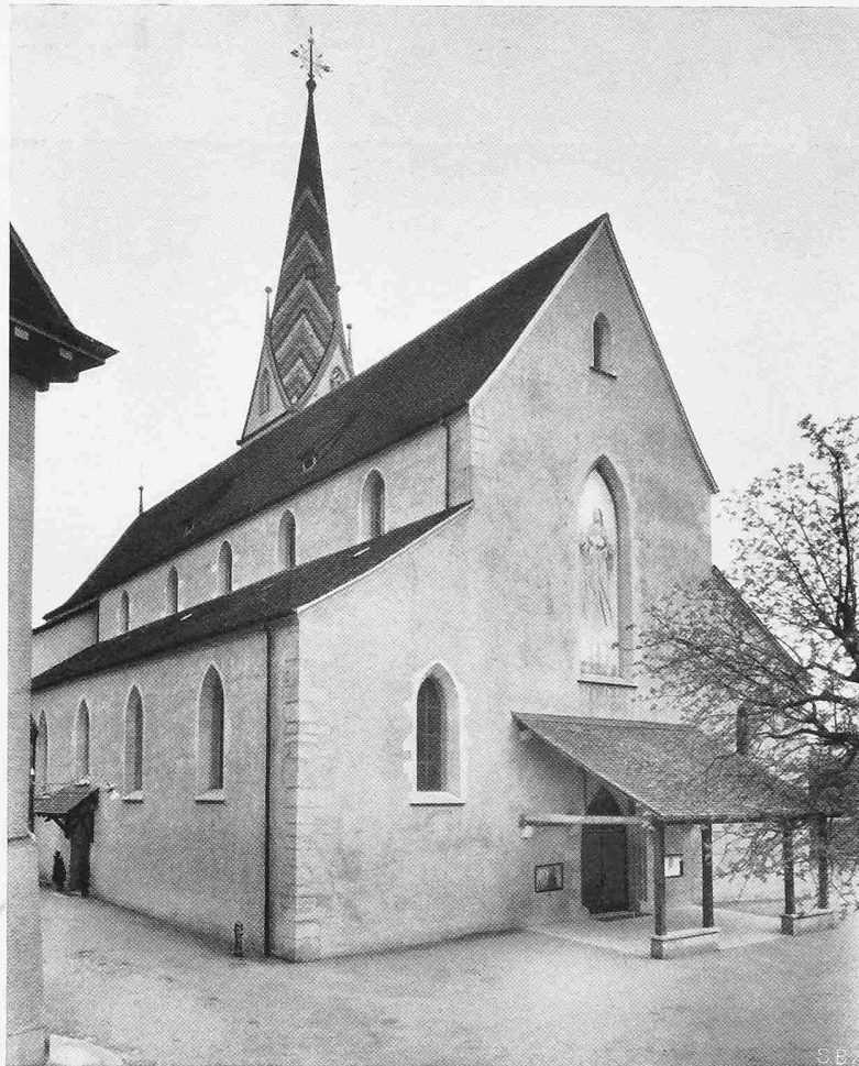
Die neue Westfassade der Stadtpfarrkirche. In der Fensternische Auffahrt Mariae von P. Bodmer (Mosaik)
