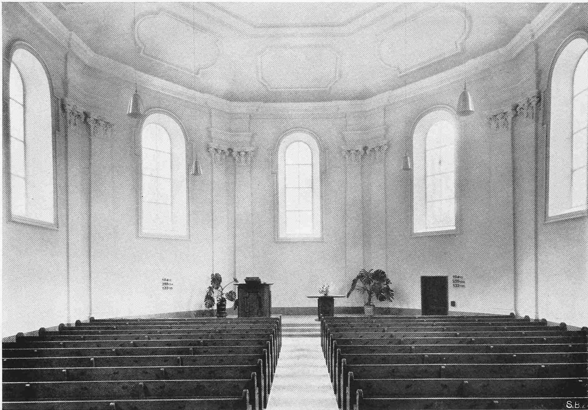
Reformierte Kirche Baden, erbaut 1713/14, Blick gegen die Kanzel nach der Restauration von 1949
