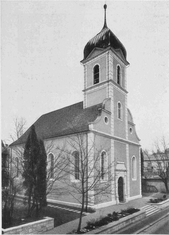
Reformierte Kirche Baden, erbaut 1713/14, Ansicht aus Süden
