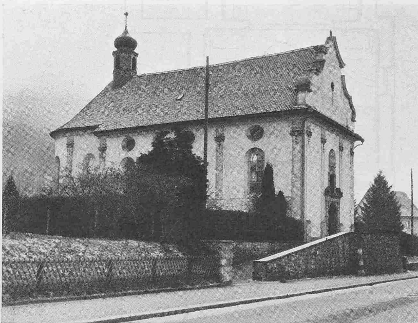
Nordostansicht vor der Restauration (vgl. Tafel 19 unten)
