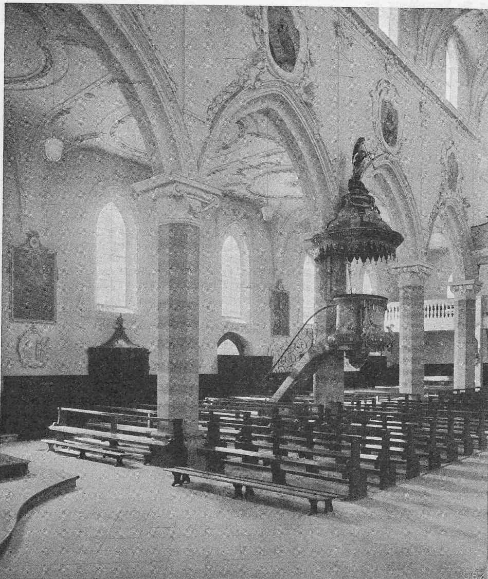
Blick in das Seitenschiff und gegen die Empore, Renovation 1936/37
