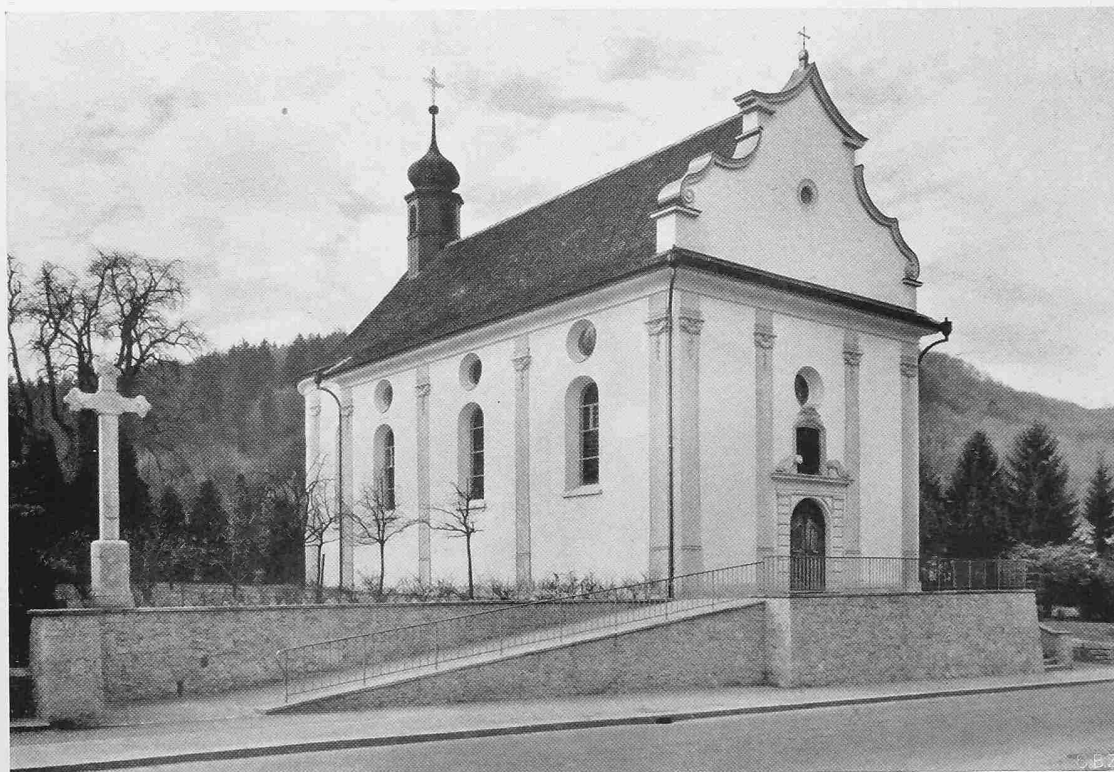
Wallfahrtskapelle Maria Wil bei Baden, aus Nordosten. Erbaut 1660, barockisiert 1764, renoviert 1950
