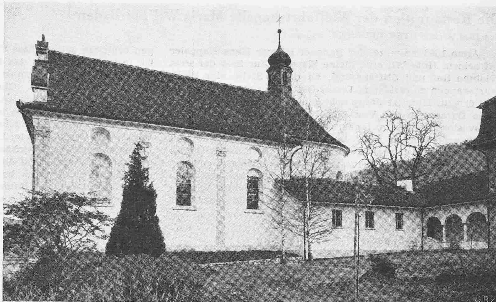
Wallfahrtskapelle Maria Wil an der Strasse Baden-Turgi, Westansicht nach der Restauration
