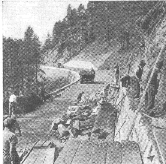
Verlegung der Julierstrasse in Marmorera
