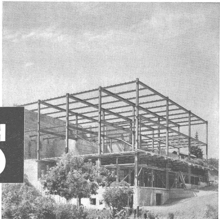
Stahlskelett für Fabrikneubau
