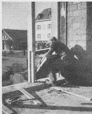
Bilder 9 bis 11. Versetzen der vorfabrizierten Kunststeinbrüstungen
