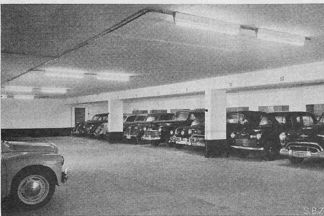
Bild 7. Garageraum mit bergseitigem Unterzug und Boxenreihe
