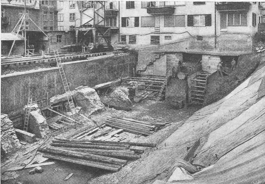
Bild 8. Unterfangung der Boxenreihe und des Hauses Huttenstrasse 61
