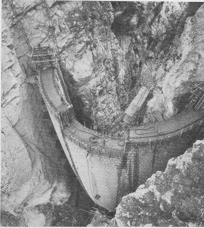
Bild 28. Staumauer Valle am Boite. Ansicht von oben. Bauzustand Oktober 1950
