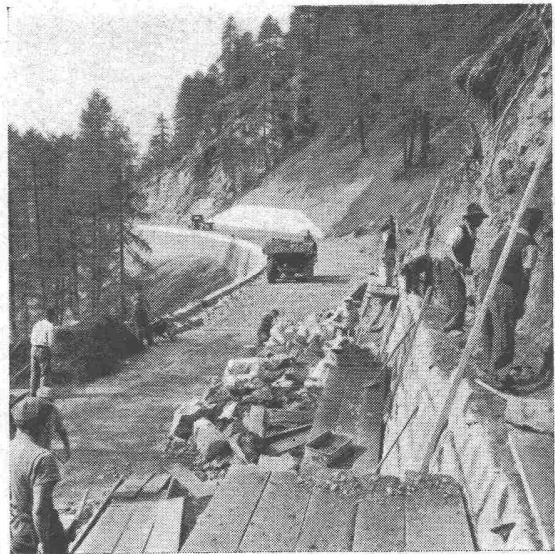
Verlegung der Julierstrasse bei Marmorera
