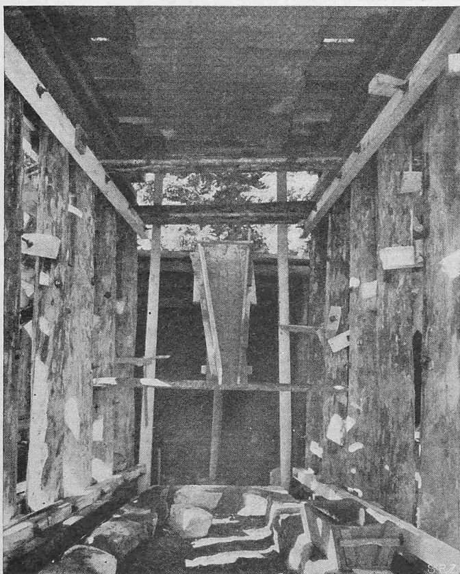
Bild 17. Bauzustand nach dem Abbruch des Pfeilers, Innenbild
