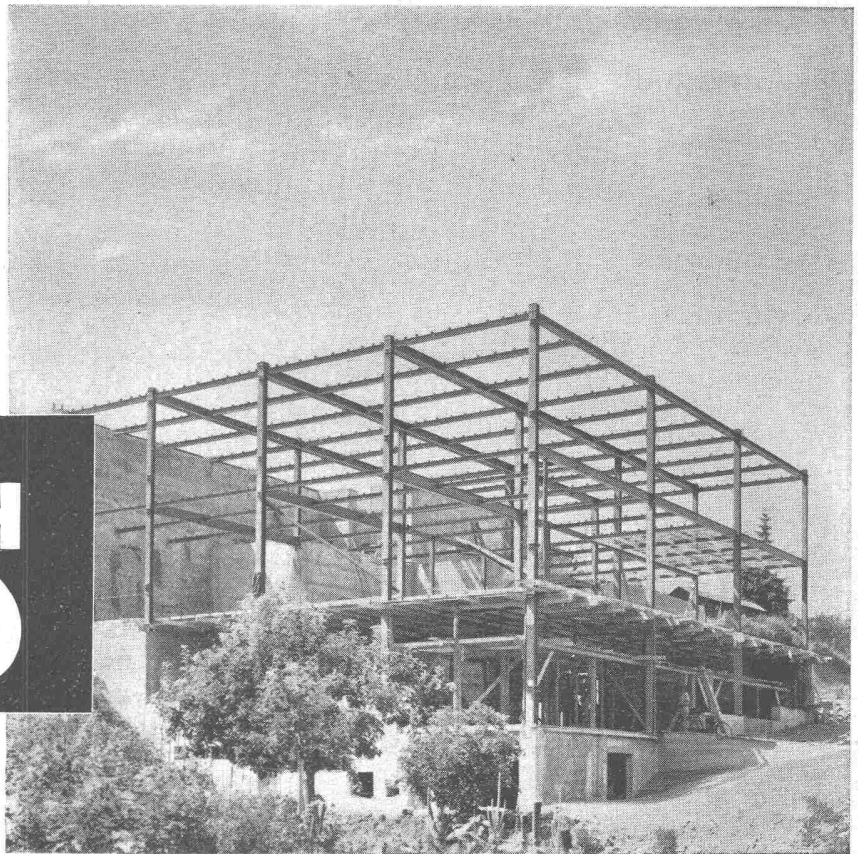
Stahlskelett für Fabrikneubau
