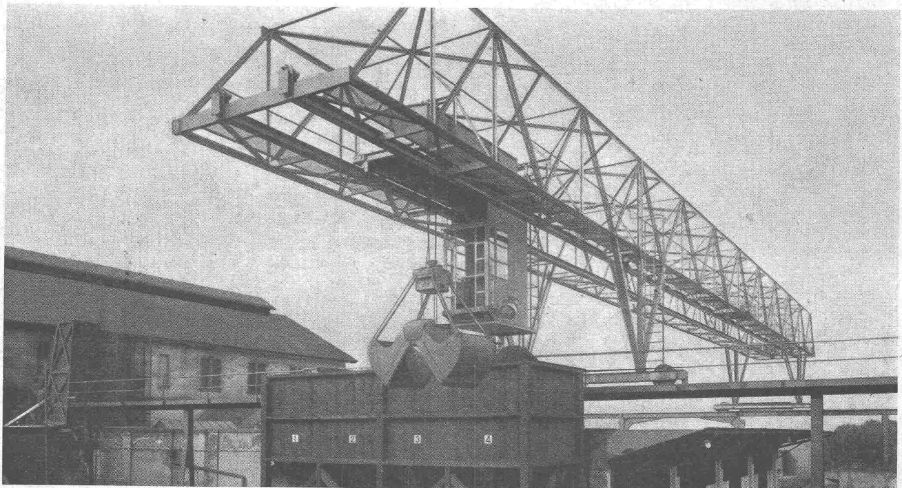
Verladebrücke in Schweisskonstruktion 2,5 t Tragkraft, 46 m Länge
