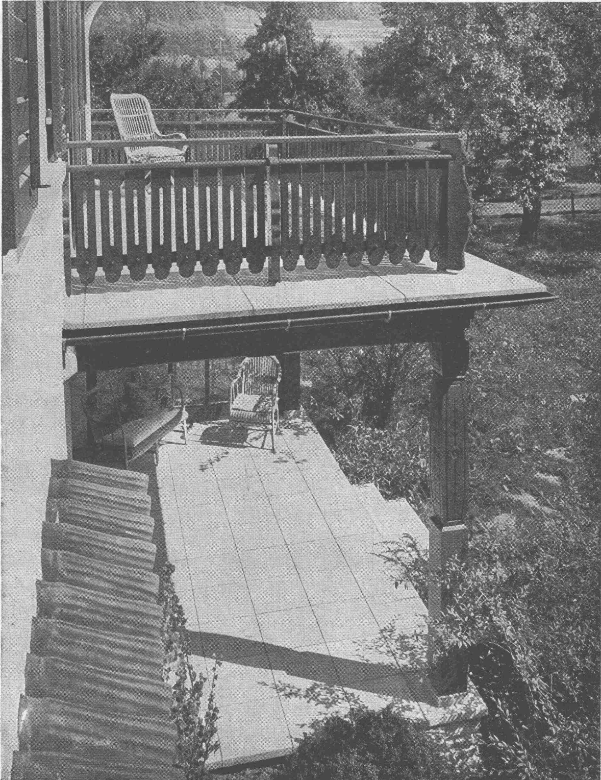
Loose SWB Zürich
