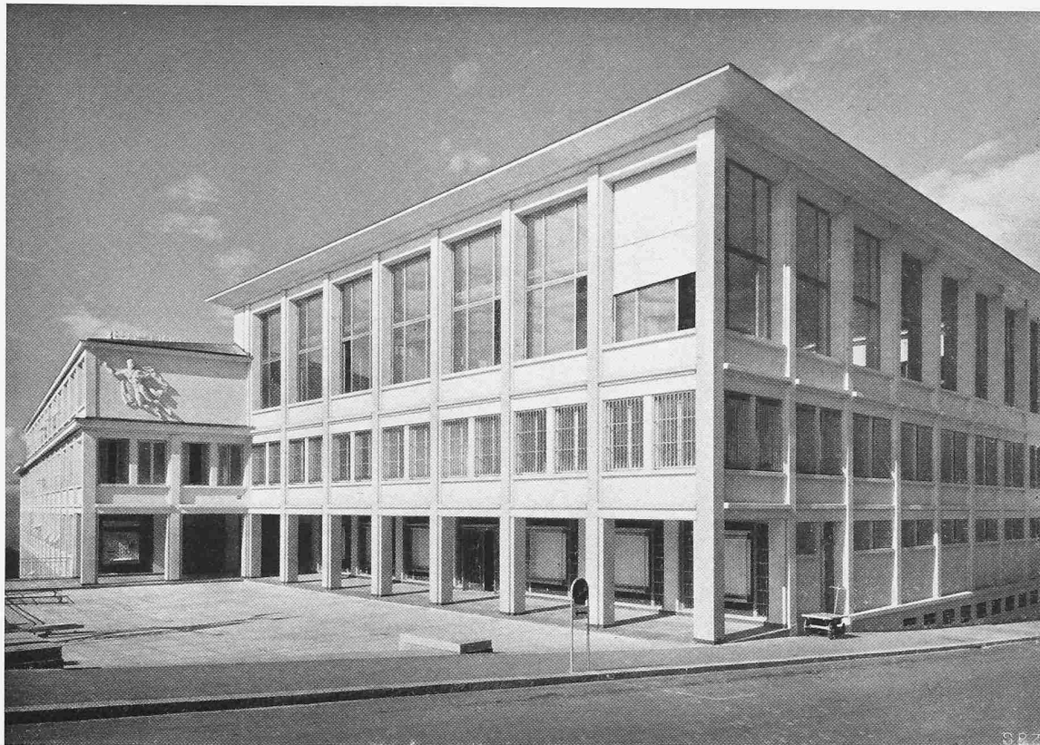
Placette au niveau du 2me sous-sol
