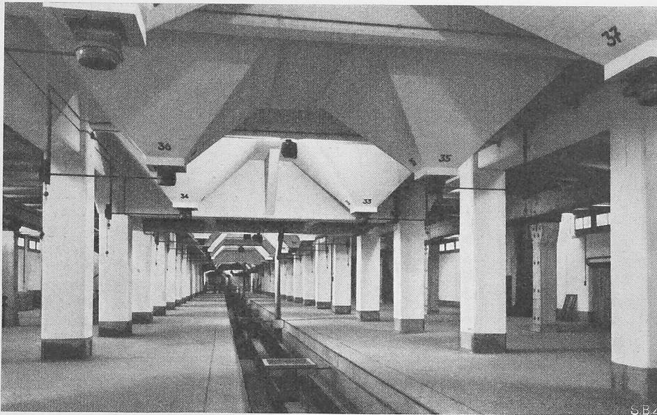
Bild 12. Siloschnauzen und Schlepperkanal im Keller
