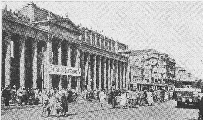
Bild 3. Der anschliessende Königsbau, eine feindetaillierte Kolonnade aus dem Ende des 19. Jahrhunderts, ist durch hässliche Reklamen fast noch mehr verunstaltet als durch die noch ungeheilten Wunden der Fliegerbomben.
