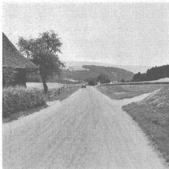
Strasse mit Bodenvermörtelung
