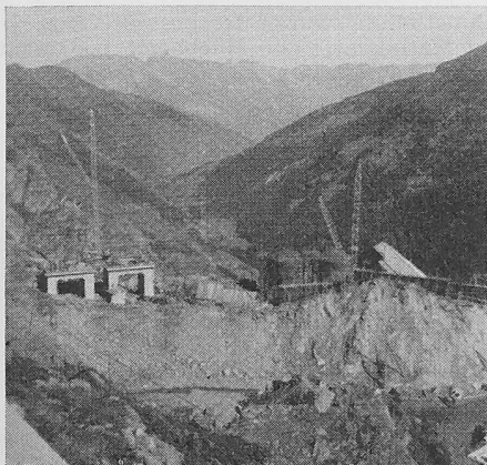
Chantier de Blava; à droite: station d'arrivée du téléphérique et silos à ciment, à gauche: socles des tours à béton, au centre: Val des Dix, vers Sion, au fond: Alpes bernoises, avec Wildhorn.
