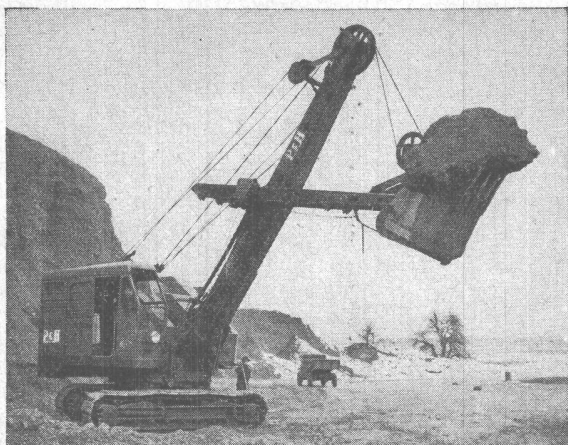
Löffelbagger mit Tru-Lay-Brugg-Drahtseilen ausgerüstet
