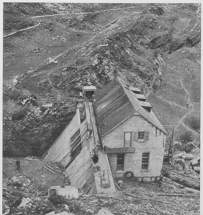
Bild 5. Das Pumpenhaus mit Wasserfassung; im Hintergrund die Erdaufschüttung für die Druckleitung
