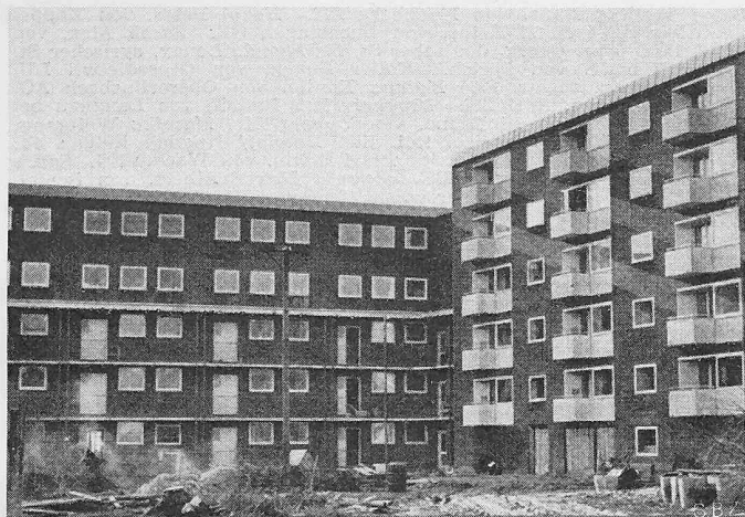
Bild 41. Hoje Soborg, Blick gegen Hauptbau mit Laubenganghaus.
