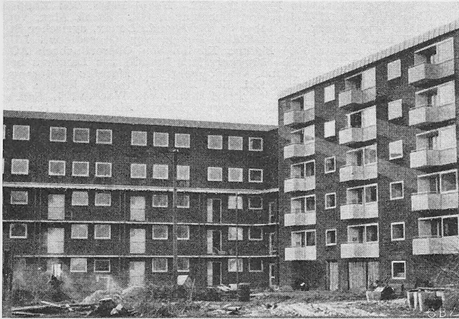
Bild 41. Hoje Soborg, Blick gegen Hauptbau mit Laubenganghaus.
