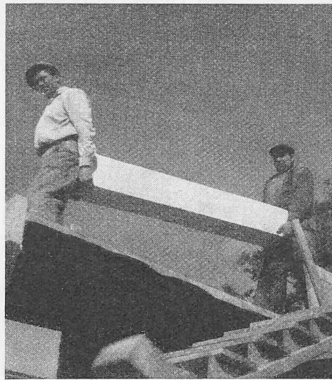
Bilder 7 und 8. Die Anwendung von Leichtbeton-Bausteinen verkürzt die Arbeitszeit wesentlich. Bild 9. 15 bis 20 cm dicke innere Eisenbetonwand mit äusserer Siporex-Isolierung von 7,5 bis 15 cm Stärke, leicht an der steigenden holzsparenden äusseren Schalung befestigt. Nach Herstellung der inneren Schalung wird der Beton eingebracht und verdichtet. Die Haftung zwischen Beton und Siporex genügt, um die Isolierungsschale sicher zu halten.
