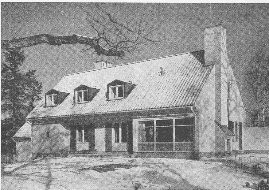
Bild 20. Einfamilienhaus aus Leichtbeton-Mauerwerk.
