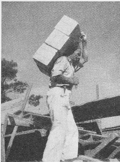
Bilder 7 und 8. Die Anwendung von Leichtbeton-Bausteinen verkürzt die Arbeitszeit wesentlich. Bild 9. 15 bis 20 cm dicke innere Eisenbetonwand mit äusserer Siporex-Isolierung von 7,5 bis 15 cm Stärke, leicht an der steigenden holzsparenden äusseren Schalung befestigt. Nach Herstellung der inneren Schalung wird der Beton eingebracht und verdichtet. Die Haftung zwischen Beton und Siporex genügt, um die Isolierungsschale sicher zu halten.
