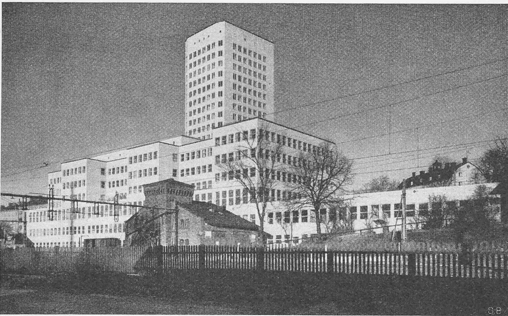
Bild 17. Hochhaus einer grossen Verlagsfirma in Stockholm. Wände aus tragendem Beton, isoliert mit 5000 m 2 Siporexplatten von 0,4 kg/dm 3 Raumgewicht. Fassadenverkleidung mit hellen Ziegelstäben in Mörtel verlegt.
