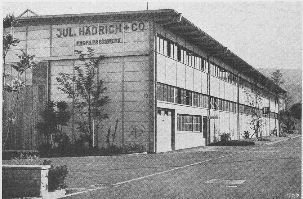
Bild 7. Industriebau in Zürich, Durisol-Plattenbauweise mit Stahlskelett, äussere senkrechte Deckstreifen in galvanisiertem Eisen, Architekten H. A. FURRER & A. V. DIEMAND, Zürich
