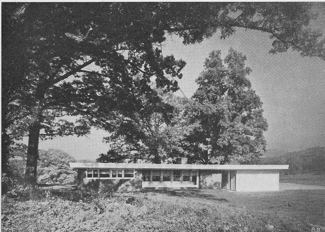
Bild 4. Landhaus bei New York, Durisol-Plattenbauweise mit Holzskelett
