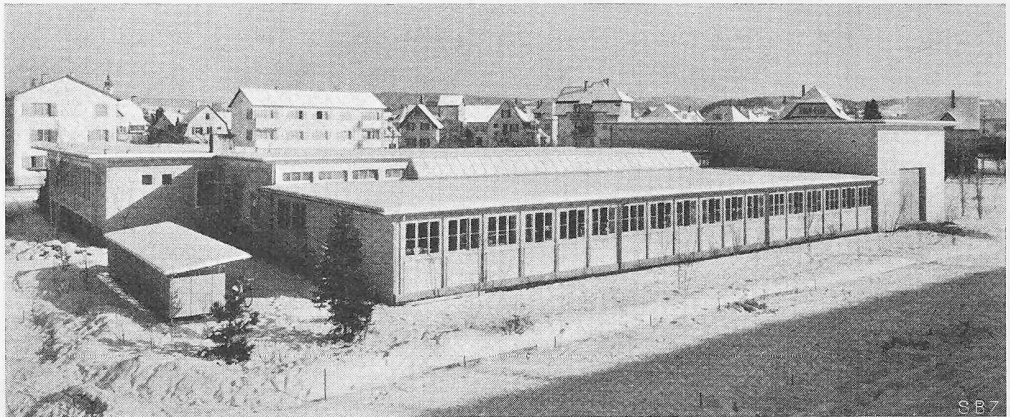
Bild 2. Gesamtübersicht der Anlage aus Nordwesten
