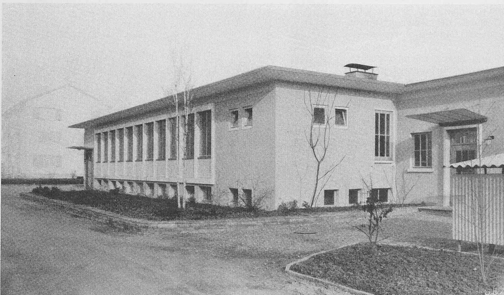
Bild 14. Bureaugebäude von Westen, rechts Eingang zur Werkstätte
