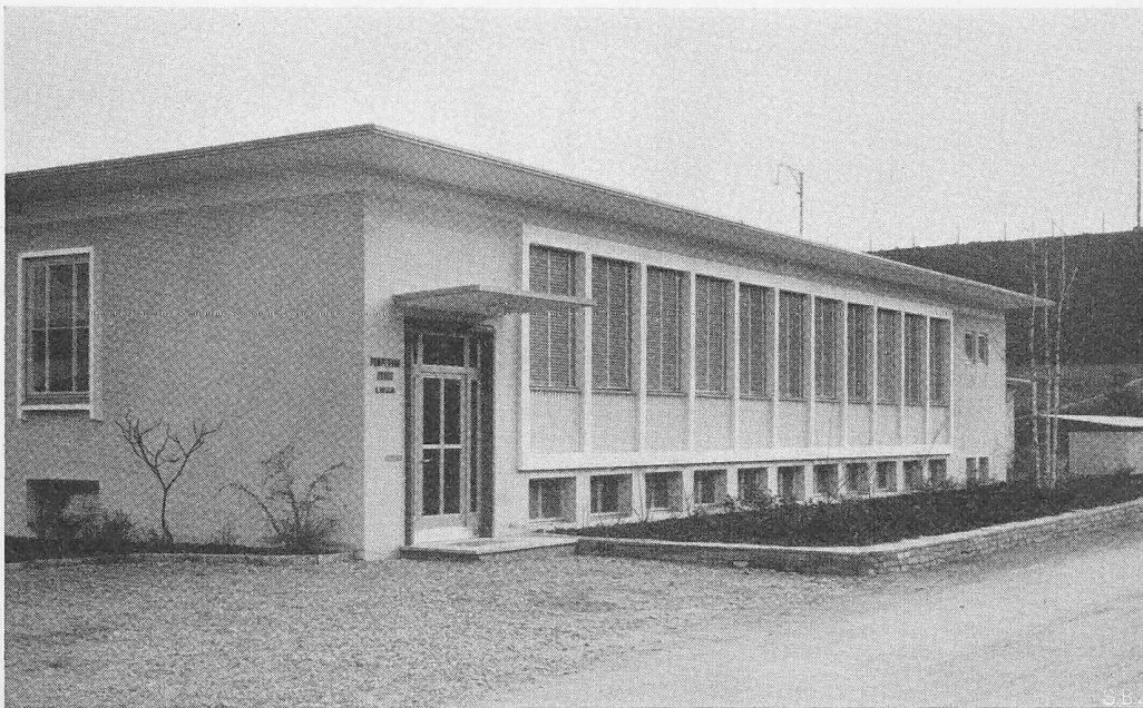
Bild 13. Eingang zum Bureaugebäude
