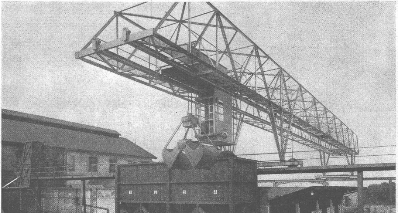
Verladebrcke in Schweisskonstruktion 2,5 t Tragkraft, 46 m Lnge
