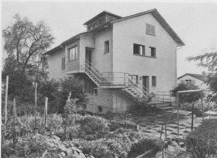
Ansicht der Aussentreppe Rotfluhstrasse 17
