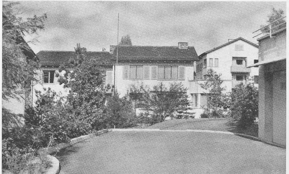
Doppelfamilienhaus Rotfluhstrasse 23, Ansicht aus Süden
