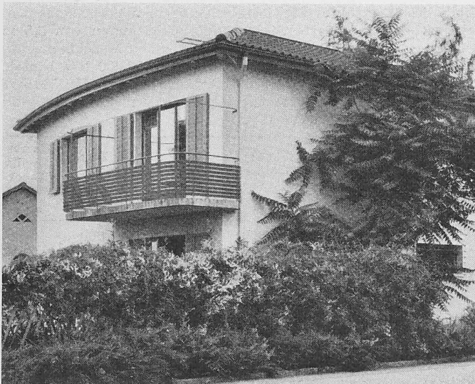
Ansicht aus Südosten
