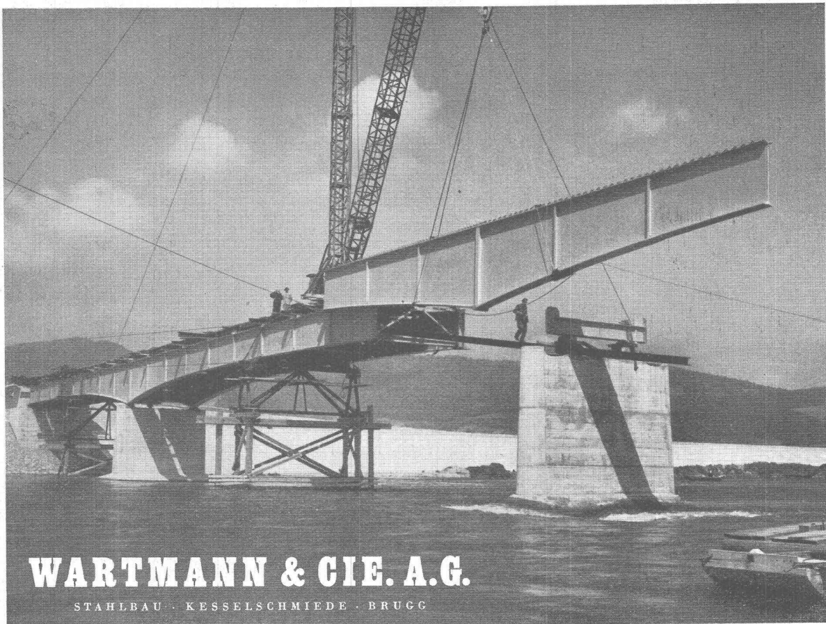
Montage der neuen geschweissten Brücke über die Aare bei Schinznach-Bad
