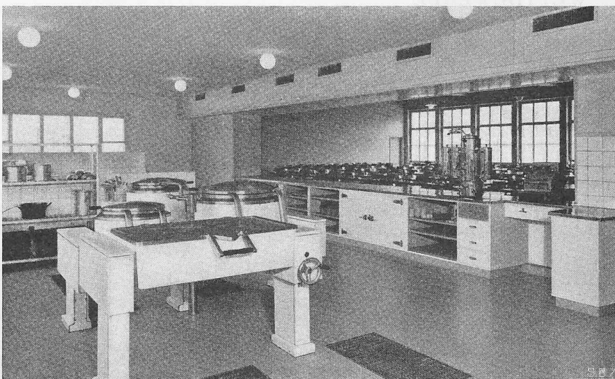
Bild 8. Küchenanlage mit Blick gegen Arbeiterspeisesaal.
