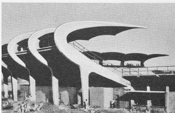
Bild 35. Tribüne des Baseballstadions in Cartagena (Columbien). Schalen zwischen Trägern ohne Stützen, vgl. Bild 6 [5].
