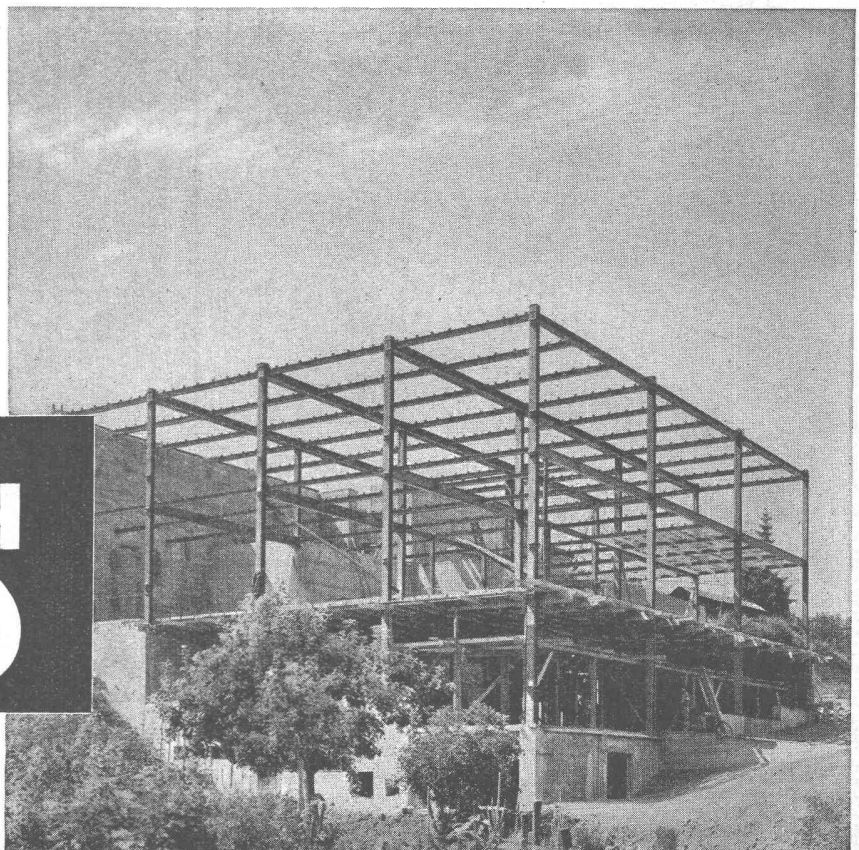
Stahlskelett für Fabrikneubau
