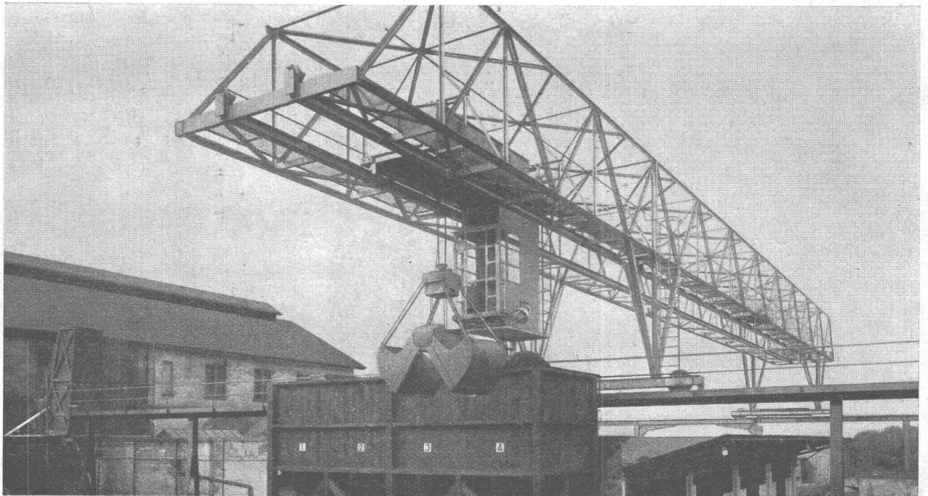
Verladebrücke in Schweisskonstruktion 2,5 t Tragkraft, 46 m Länge
