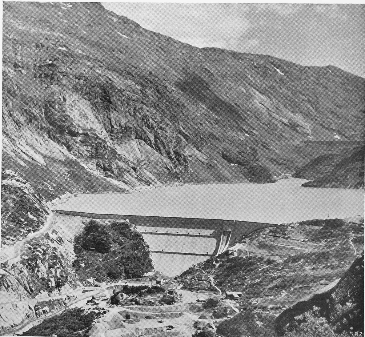
Staumauer Räterichsboden, darüber (rechts am Bildrand) die Seeuferreggsperre des Grimselsees Links die verlegte Grimselstrasse
