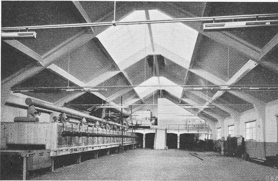
Bild 24. Fettabfüllerei mit Kühlntunnel, hinten Kirne
