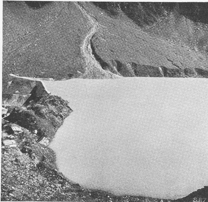
Bild 18. Die Sperrstelle Mattenalp gegen den rechtsseitigen Talhang
