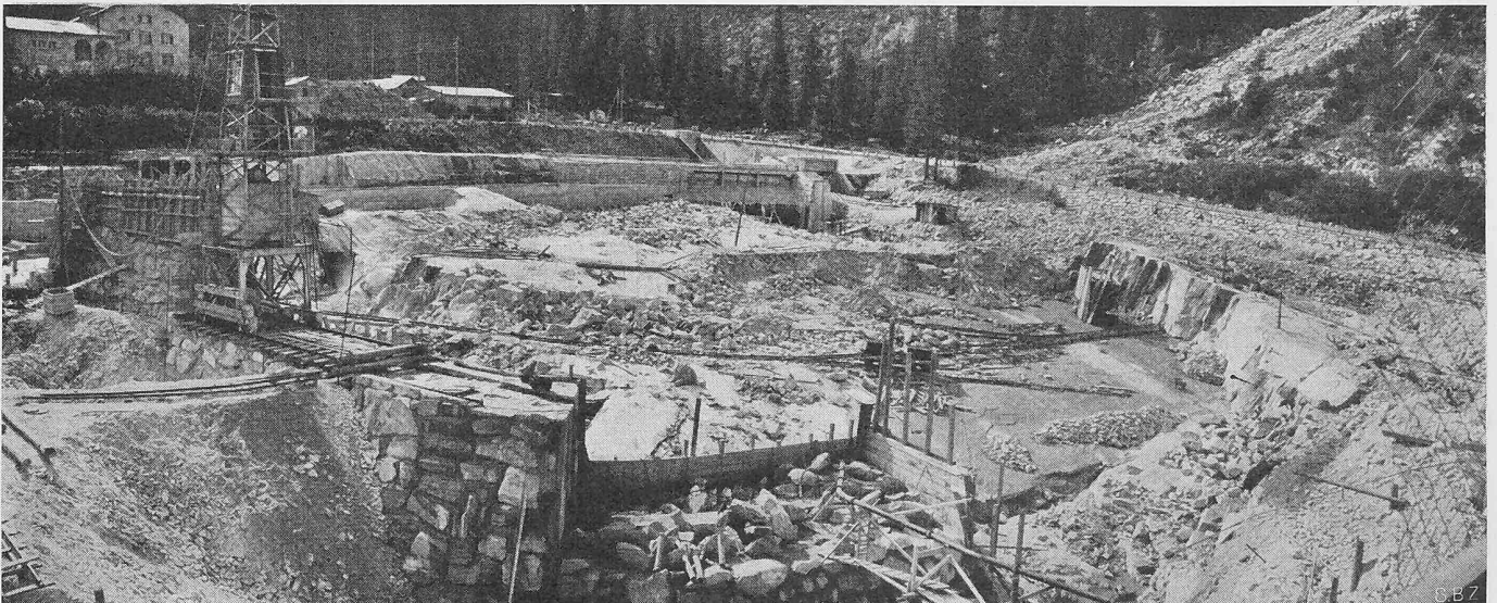
Bild 35. Ausgleichweiher Handeck, Umfassungsmauer aus Blockbeton. Bauzustand am 30. September 1946
