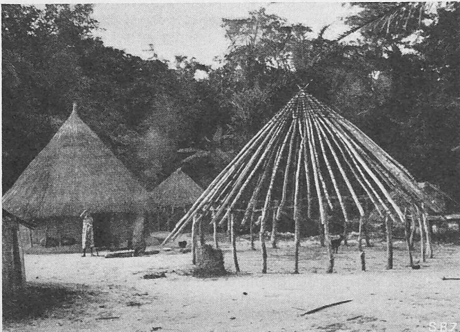
Bild 1. Zentralafrikanischer Pavillon im Bau
