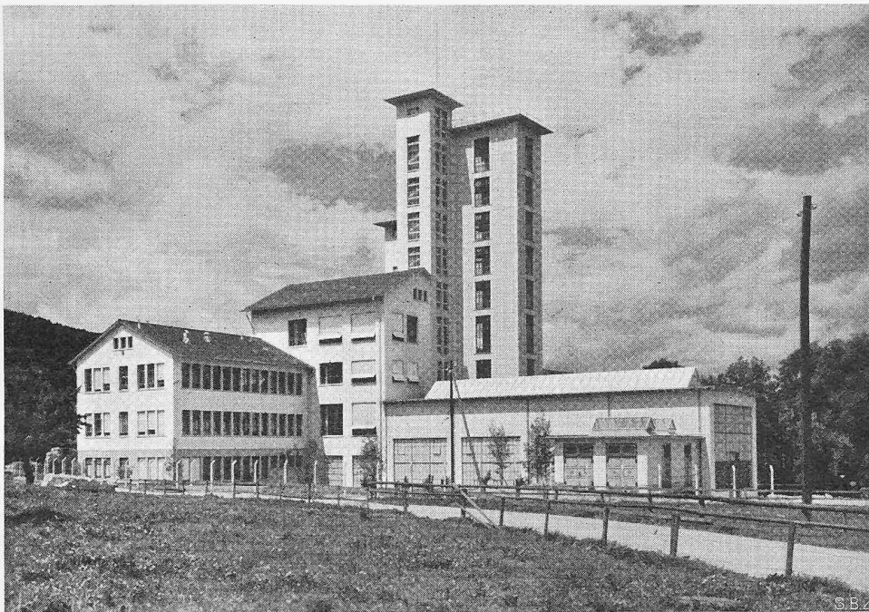
Bild 1. Links Laborgebäude, rechts Werkstatt (mit Trafostation), dazwischen Versuchsgebäude, dahinter Versuchsturm
