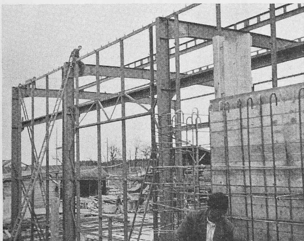
Bild 29. Montage der Werkstatt
