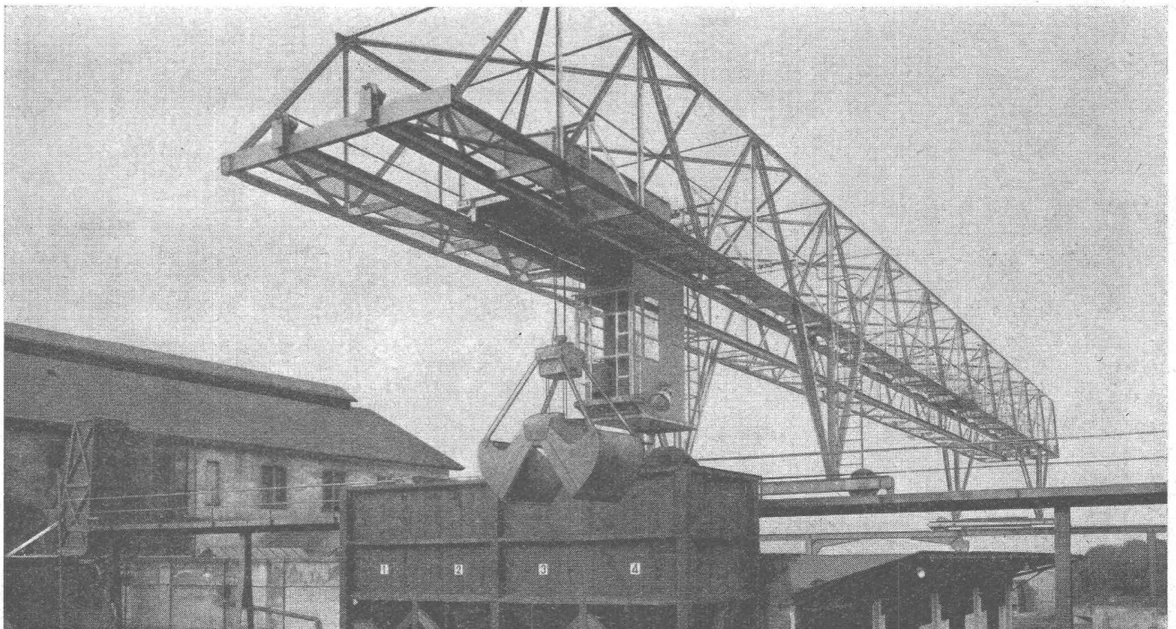
Verladebrücke in Schweisskonstruktion 2,5 t Tragkraft, 46 m Länge
