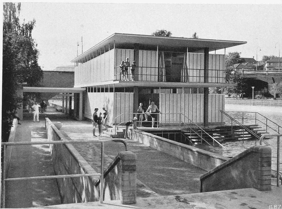
Bild 6. Eingang und Männergarderobe, links die Rampe zur Frauengarderobe, flussabwärts
