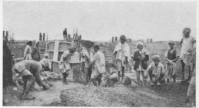
Bild 4. Betonherstellung von Hand beim Bau des Nangal-Stauwehres, 18. Jan. 1951
