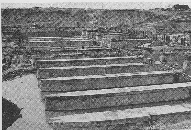
Bild 8. Nangal-Stauwehr im Bau
